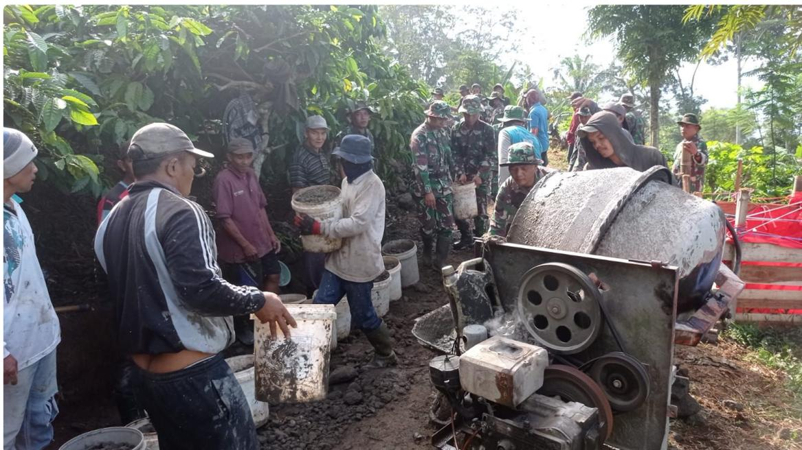
Serda Slamet Fajar salah satu anggota Satgas TMMD mengatakan mesin molen atau yang sering disebut mesin adukan cor merupakan salah satu alat yang mendukung pekerjaan pengecoran jalan, Mesin ini digunakan untuk membantu proses aduk semen.
