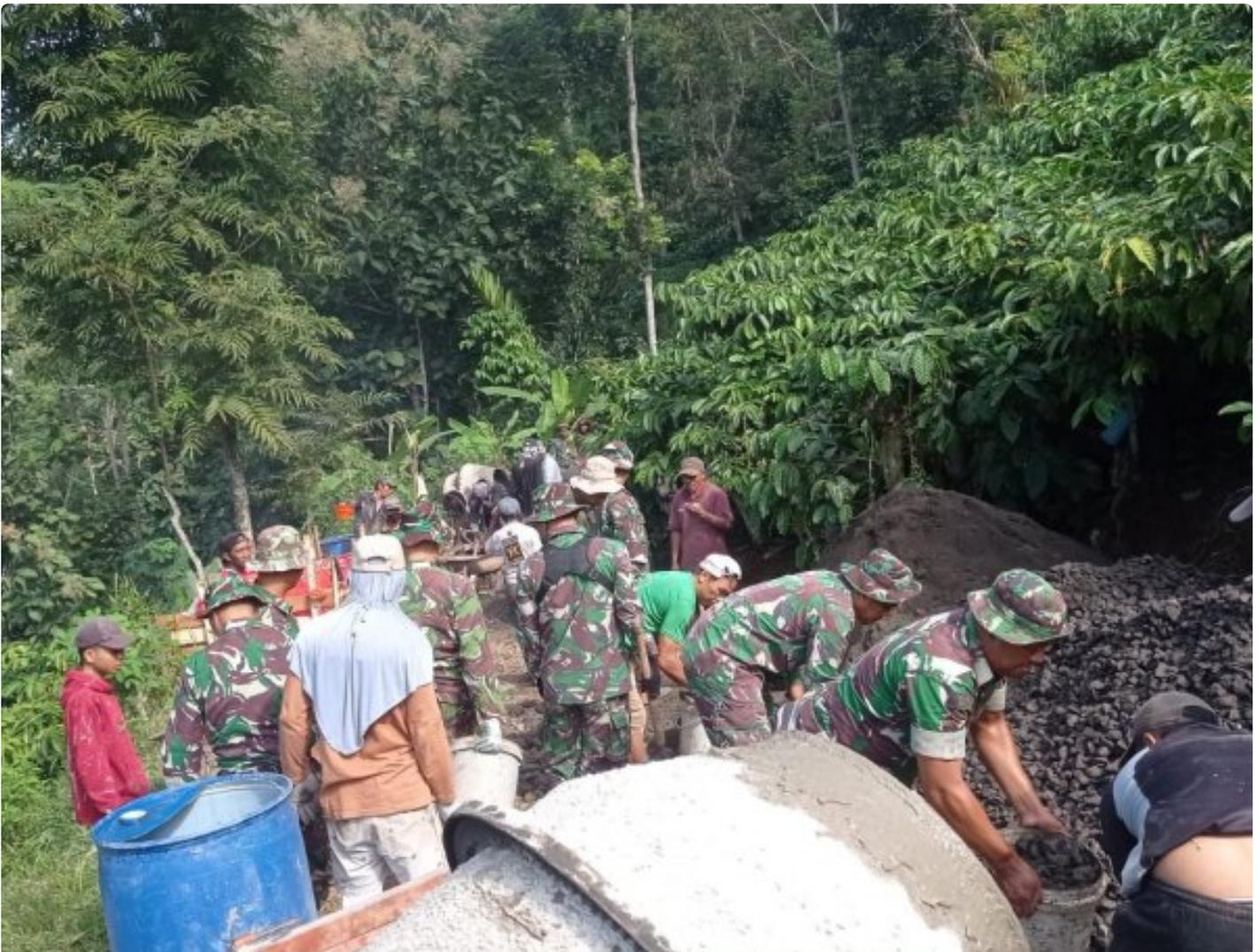
*Pengerasan Jalan Sepanjang 300 Meter Dengan Lebar 3 Meter Dan Tinggi 0,15 Meter Di Desa Karangseneng Kecamatan Gemawang Kabupaten Temanggung*
